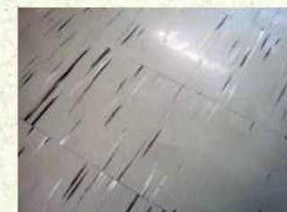
**3.4 Laminação:** nesse processo a resina é impregna em papel ou tecido, que funciona como carga ou enchimento. As folhas impregnadas pela resina são sobrepostas e comprimidas e, através do calor, produzem o plástico laminado. Exemplo: fórmica, pisos laminados plásticos (formipiso).
